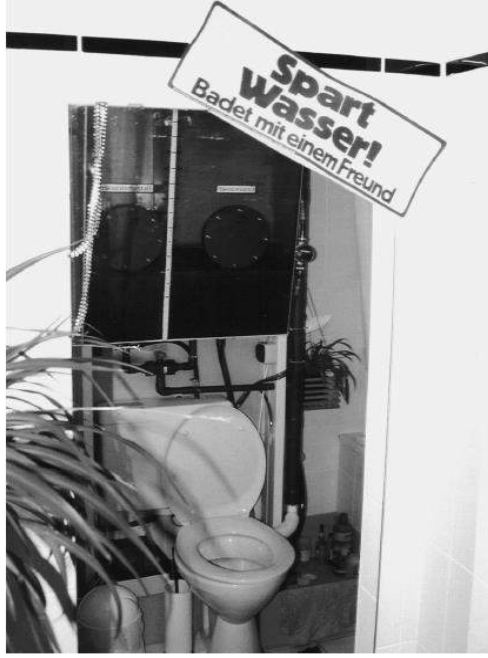
Şekil 13.8 İki kademeli gri su arıtma sistemi (Nolde, 2000)
