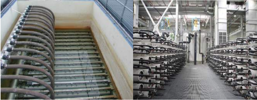
Şekil 14.21 Orange County’de kullanılan membranlara ait görüntüler: MF (solda), TO (sağda) (EPA, 2012)
