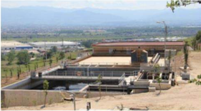
Şekil 15.18 Sızıntı suyu arıtma tesisi genel görünüşü (Dede ve diğ., 2016)
