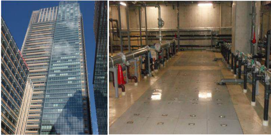
Şekil 14.31 Japonya’da su ihtiyacı geri kazanım ile sağlanan bina (solda) ve kullanılan MBR sistemi (sağda) (EPA, 2012)
