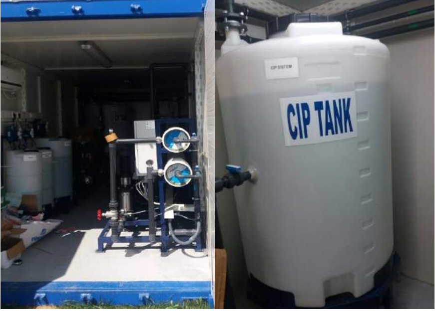
Şekil 14.40 TO sistemi konteyner yerleşimi ve kimyasal yıkama depo tankı görüntüsü
