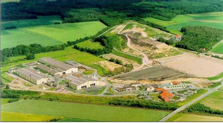
Şekil 15.21 Bassum, Almanya'da bulunan sızıntı suyu arıtma tesisinin genel görünümü (Visvanathan ve diğ., 2011)
