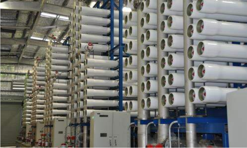
Şekil 14.28 Avustralya St. Mary's su geri kazanım tesisinde kullanılan TO sistemi (Sydneywater, 2017)
